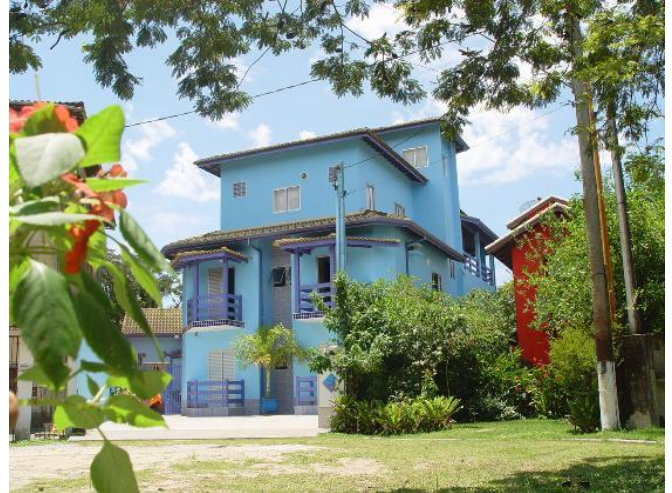
.Foto 4.3.4-3 - Fachada da Pousada DataVenia Flats , localizada na Quadra A
